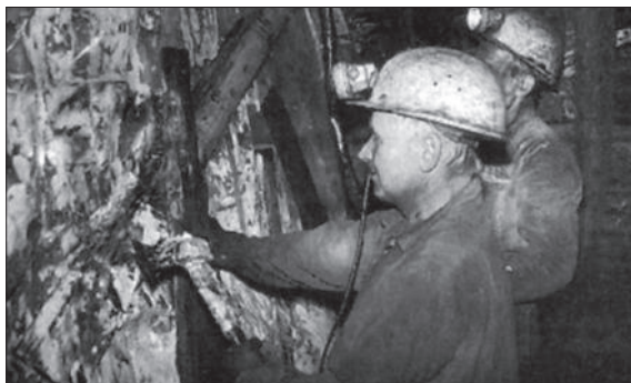
344. kép – Hagbátakat készítenek az utolsó műszakokon a szellőztetési dolgozók {4}
