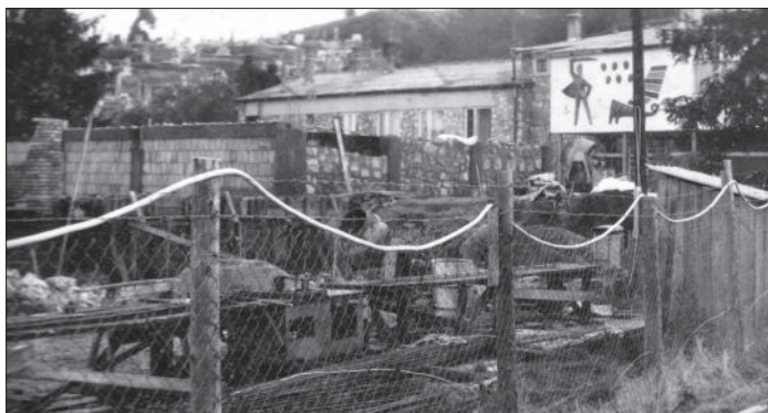
331. kép – Épül az új iskola {5}
