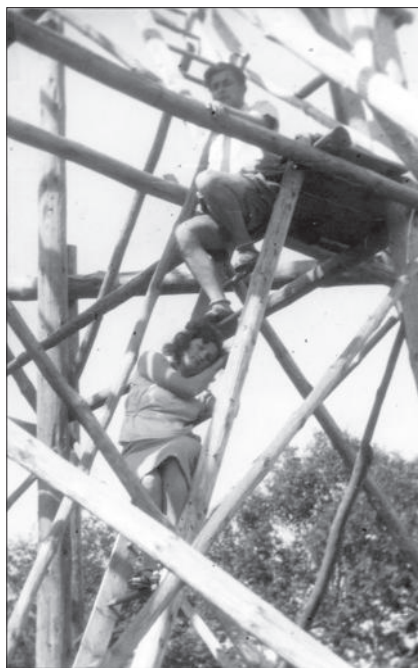
122. kép – Fénykép a kilátóról, felül Sashegyi Sándor {12}
