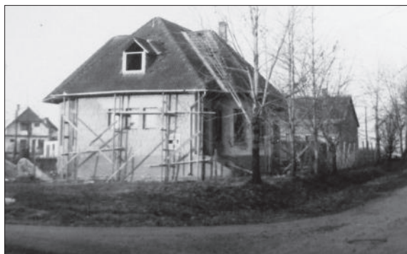
314. kép – A Bacchus presszó építése {4}
