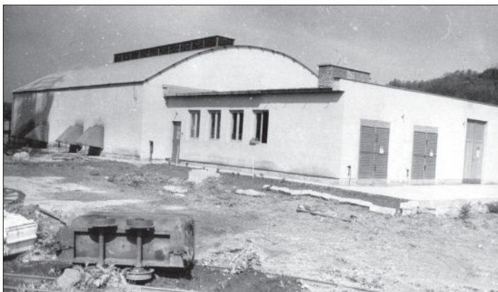
303. kép – A kompresszorház {5}
