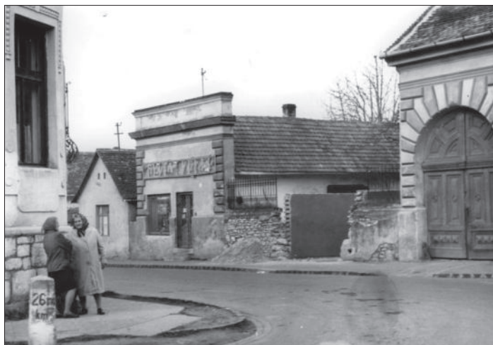
312. kép – A „Gadó-sarok”, szemben a volt Papír és Játékbolt, illetve a volt Könyvtár bejárata. A frissen vakolt falak a plébános (akko- riban a Gadó-ház lakója) autójának készülő garázs falait alkotják {4} 337
