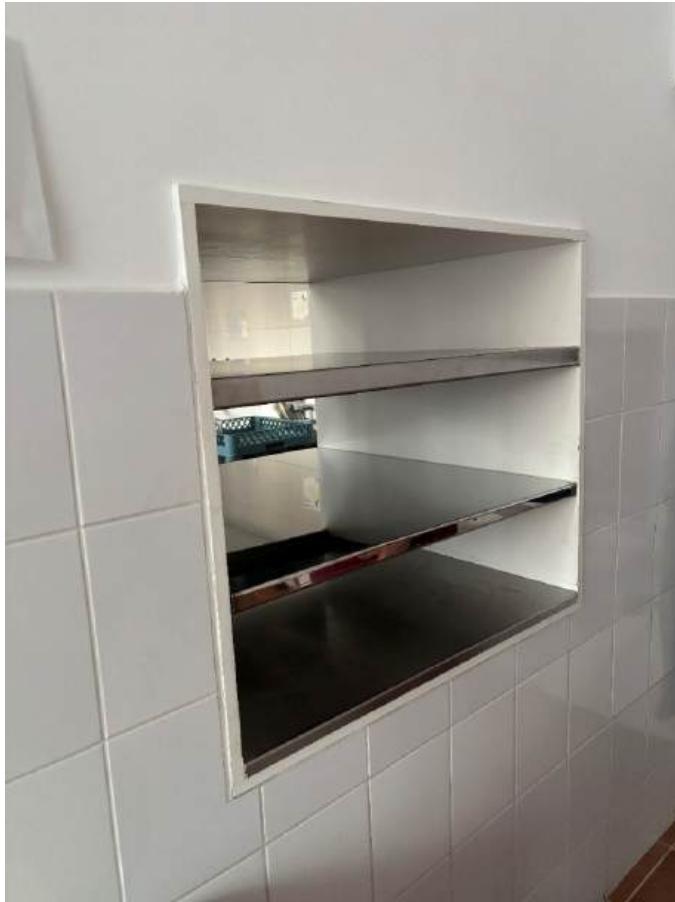
Felsőszilvási konyha ételhulladék beadó ablak bővítése plusz egy rozsdamentes polcszerkezettel.
